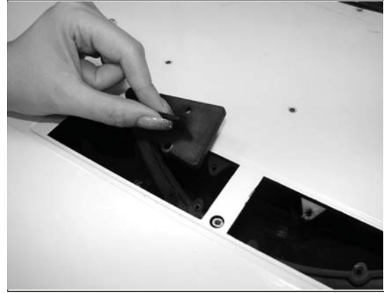
6. Enlevez les deux panneaux de reprise d'air intérieurs.
